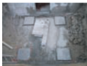
Création de 4 plots en béton
